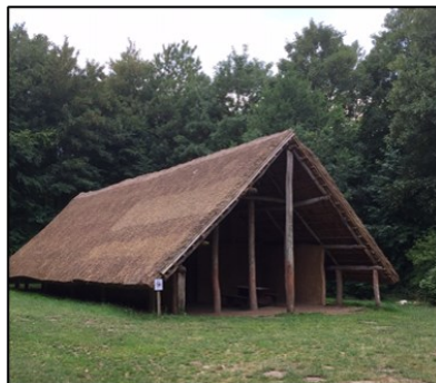
Le toit de la maison néolithique de Blaschette a été récemment rénové.
